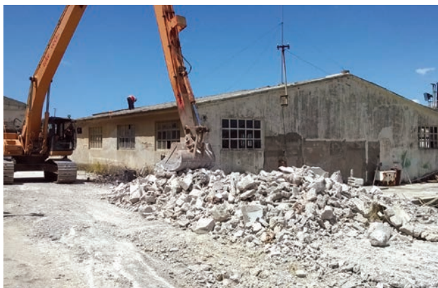
Rušenje građevina izgrađenih na pomorskom dobru
