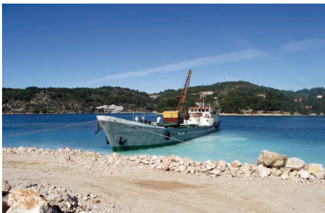
Doprema kamena za ugradnju morskim putem
