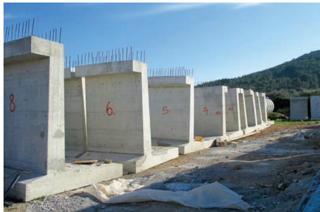
Predgotovljeni L elementi pripremljeni za ugradnju
