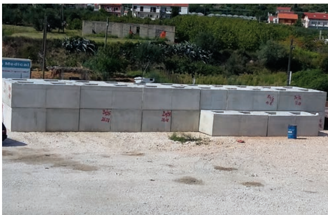
B elementi koji se proizvode na gradilištu čiovskog mosta
