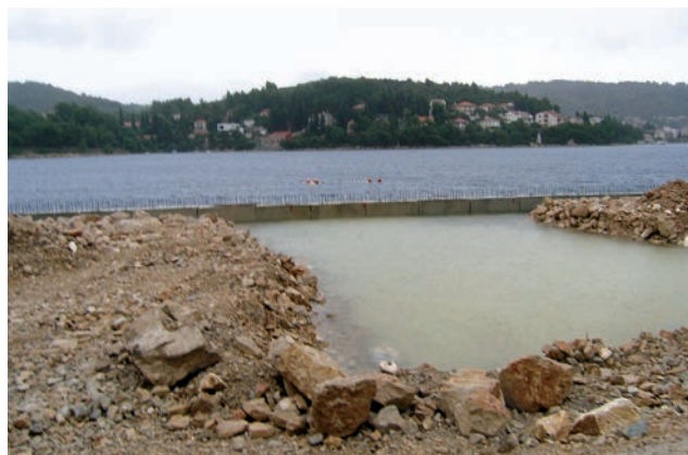
Podzemna morska voda u iskopu
